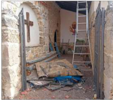
Los trabajos van a buen ritmo, según confirma el párroco. R.F.
